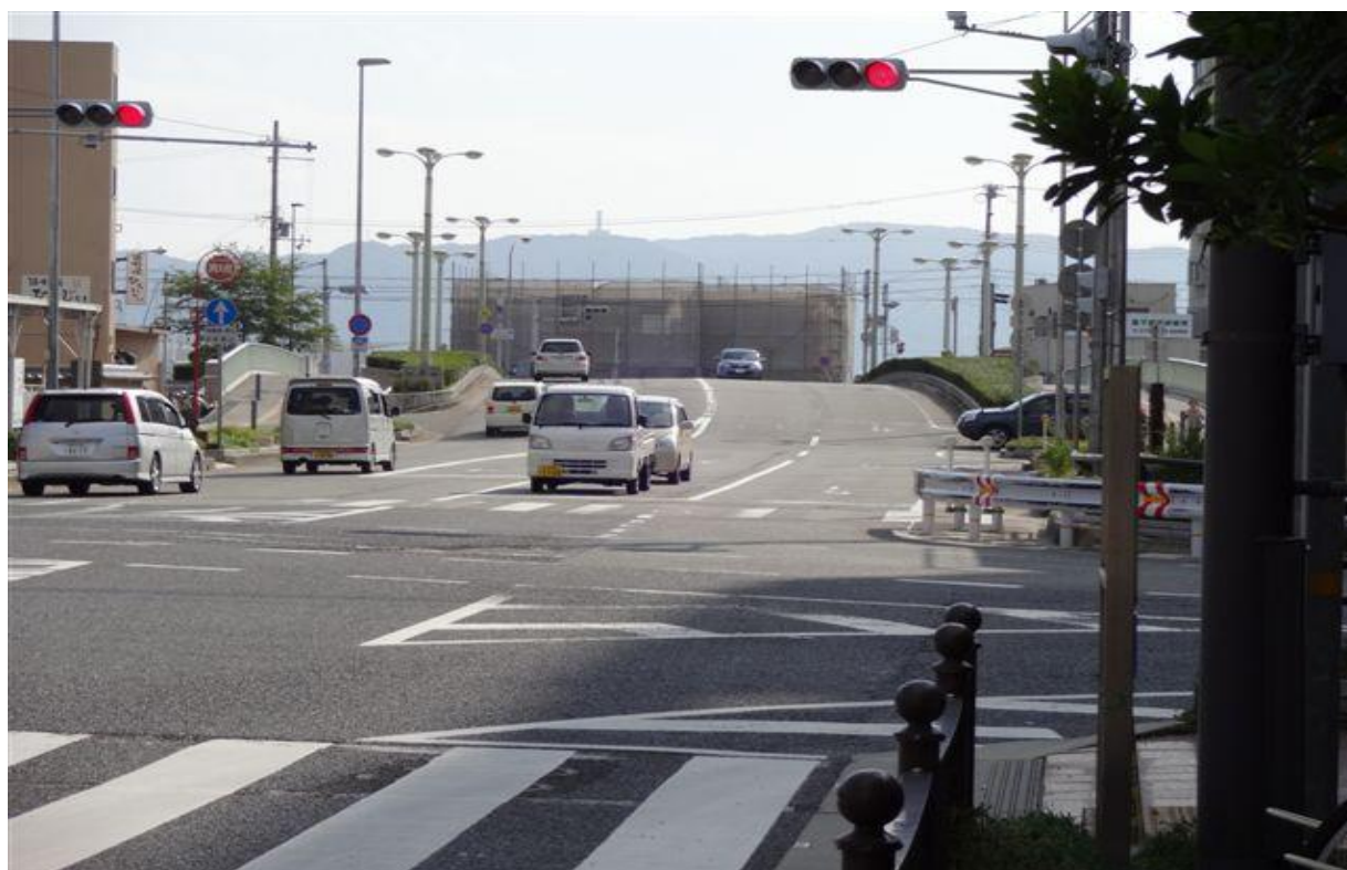
② 錦江橋北側、銀座通り南詰の本町通りとの交差点からの眺望。正面の建物はマンション販売事務所。錦江橋が銀座通りの延長線に真っすぐ延びているのではなく、東（左手）に振っているのが分かる。マンション用地東側の商業用地？に平屋建てのコンビニ建物が建つ程度でも、海峡への視界はふさがれる。正面建物のすぐ右手には15階建てマンションがそびえるはず。
