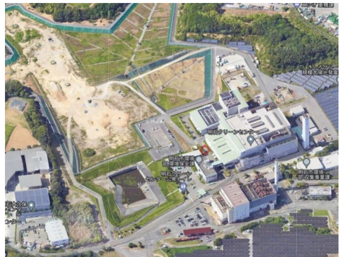
右下の旧施設を解体して新施設を建設。右上は現施設。
